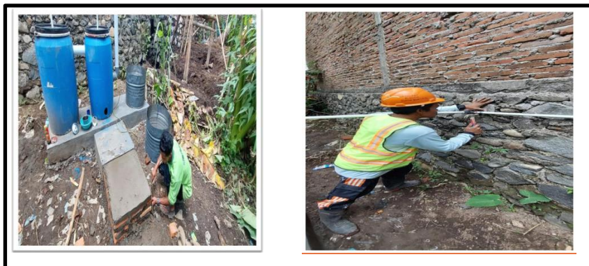
Gambar 1. Pemasangan digaster dan instalasi biogas
