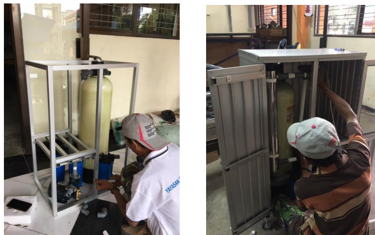
Gambar 5. Proses dan Produk Instalasi air minum yang telah dihasilkan
