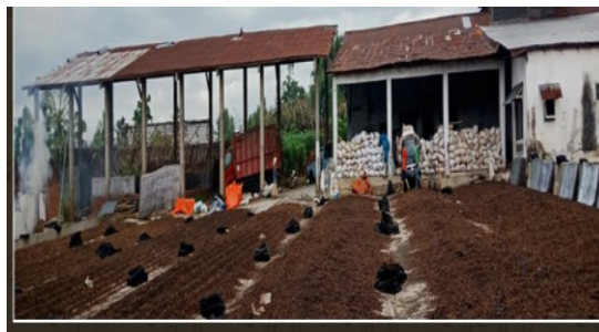
Gambar 1. Pabrik Produksi, Pengolahan dan Gudang Penyimpanan Biji Kopi Robusta KSU Ketakasi
