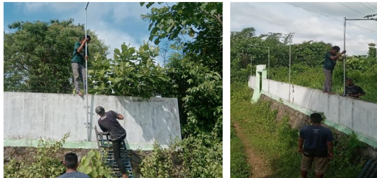
Gambar 6. Proses Pemasangan PJUTS
