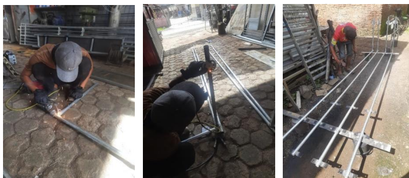
Gambar 3. Proses pembuatan tiang panel surya
