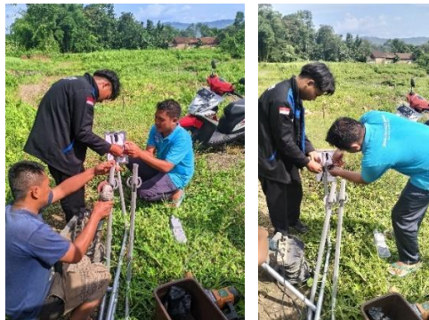
Gambar 5. Proses Perakitan PJUTS
