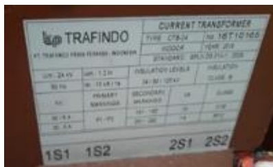
Gambar 2. Spesifikasi Pada CT ( Current Transformer )
