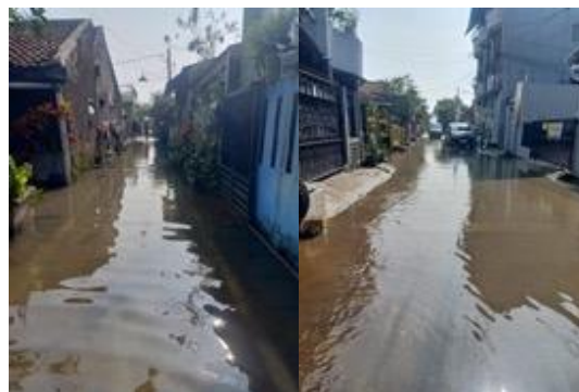
Gambar 1. Kondisi Banjir di Lokasi Studi (Sumber : Dokumentasi Penelitian, 2025)
