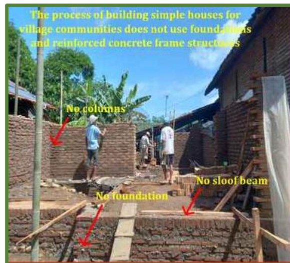
Gambar 1. Rumah sederhana pedesaan tidak menggunakan pondasi dan struktur rangka beton bertulang
