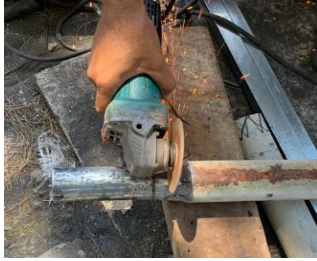
Gambar 5. Pemotongan pipa besi untuk casing generator
