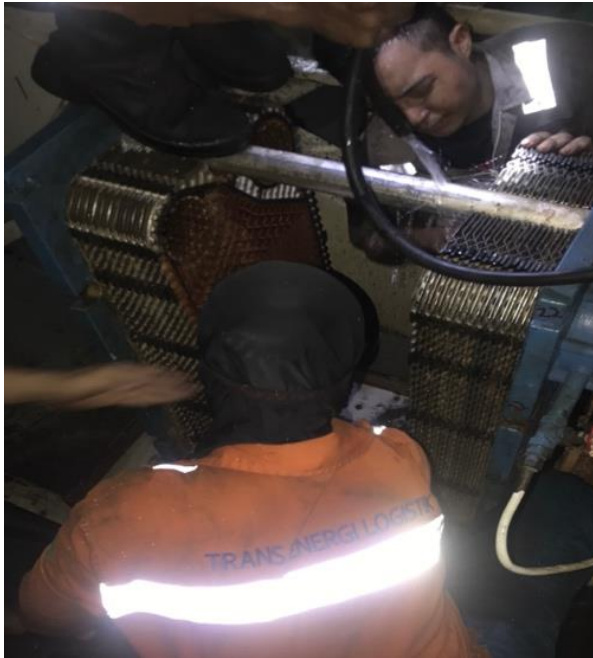
Gambar 6. Cleaning cooler Kompresor udara
