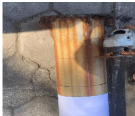
Gambar 12. Pemotongan Pipa Besi untuk Casing Generator
