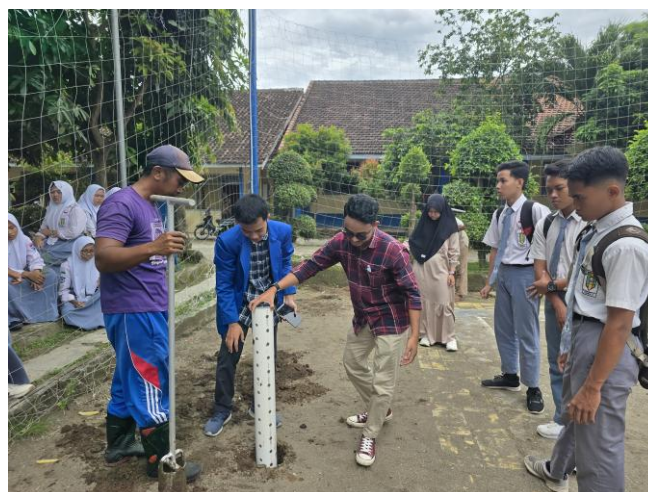
Gambar 1. Kegiatan Pembuatan Lubang Biopori oleh Siwa dan Guru
