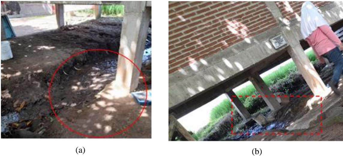
Gambar 1. Pengikisan struktur fondasi pada bangunan kelas akibat aliran air
