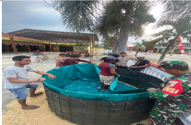
Gambar 2. proses pemasangan terpal bagian dalam kolam bersama babinsa dan warga
